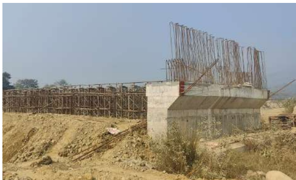
सजुरा खोलाको निर्माणाधीन पुल
